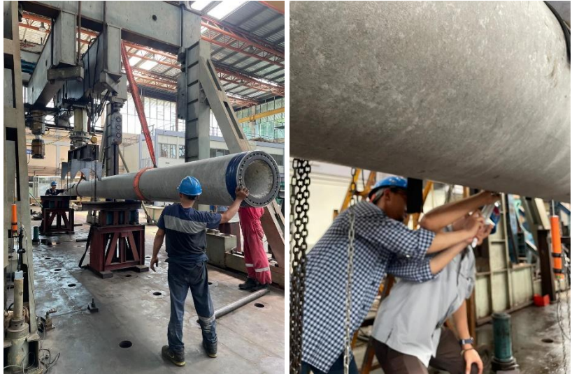
Gambar 4. Set up tiang pancang ( spun pile ) dan pengecekan crack
